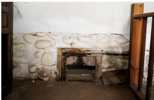
圖 11 林北卡好菸樓的本灶牆面底部仍可見卵石痕跡。 （資料來源：筆者攝，拍攝日期：2025 年 06 月 20 日）
