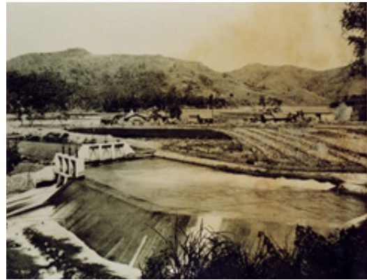
圖 6 公共埤圳獅子頭圳斗型水槽（資料來源：高雄州寫真帖）（不詳 1923：26）
